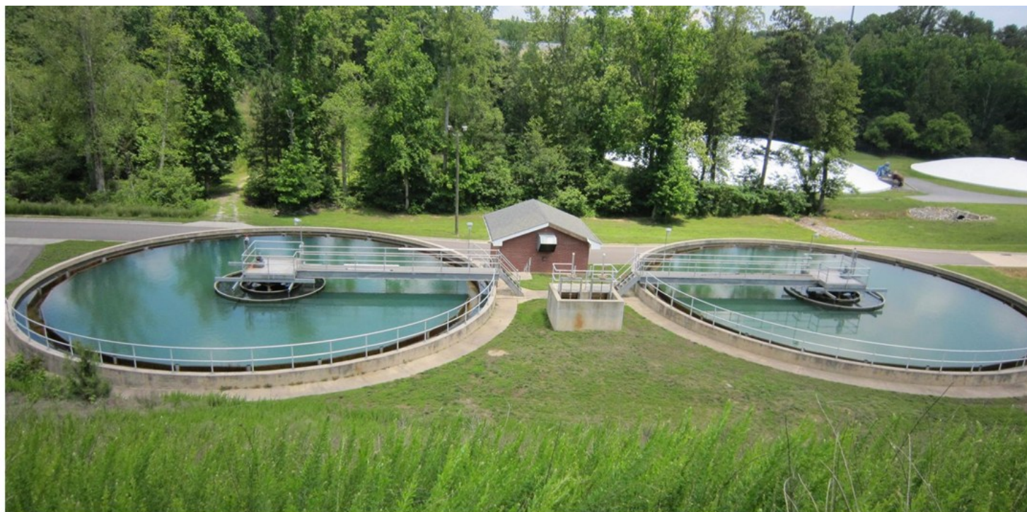
Planta de tratamiento de agua
